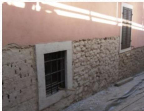
3. Esecuzione dello strato finale mediante applicazione di rivestimento preconfezionato **STABILITURA**, di colore bianco naturale, composto di calce aerea in polvere ad alto titolo d'idrato di calcio  $[Ca(OH)_2]$ , specifiche pozzolane naturali selezionate e sabbia bianca di Sacile selezionata in curva continua con granulometria massima di 0,7mm.
