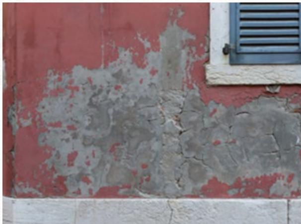
L'umidità ascendente è la responsabile principale dei danni e del degrado di un edificio soprattutto se antico o vecchio e la si deve attribuire a due fattori principali come la presenza d'acqua nel sottosuolo e la porosità del materiale di costruzione.
