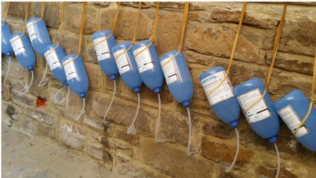
**BARRIER ACQUA PLUS - SISTEMA A CADUTA** necessita di un foro di entrata con un diametro di appena 10 - 12mm; questo permette di forare solo la malta cementizia tra i materiali, al contrario di quanto accade in altri sistemi che utilizzano connettori e cannule con diametro più grande danneggiando il materiale che costituisce la muratura stessa a livello estetico e comportando la necessità di un ripristino sulle murature faccia a vista.
